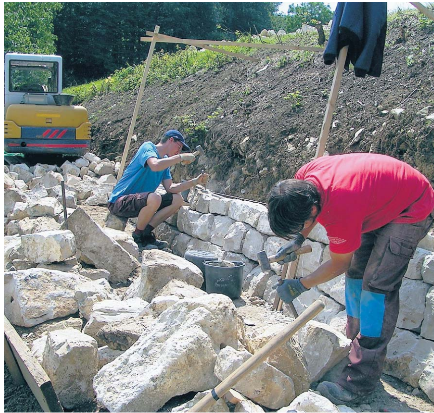
Kalkstein um Kalkstein wird die Trockenmauer bis auf 1,6 m Höhe aufgebaut.
