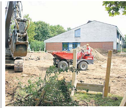
Hier wird für den neuen Kindergarten gebaut.
